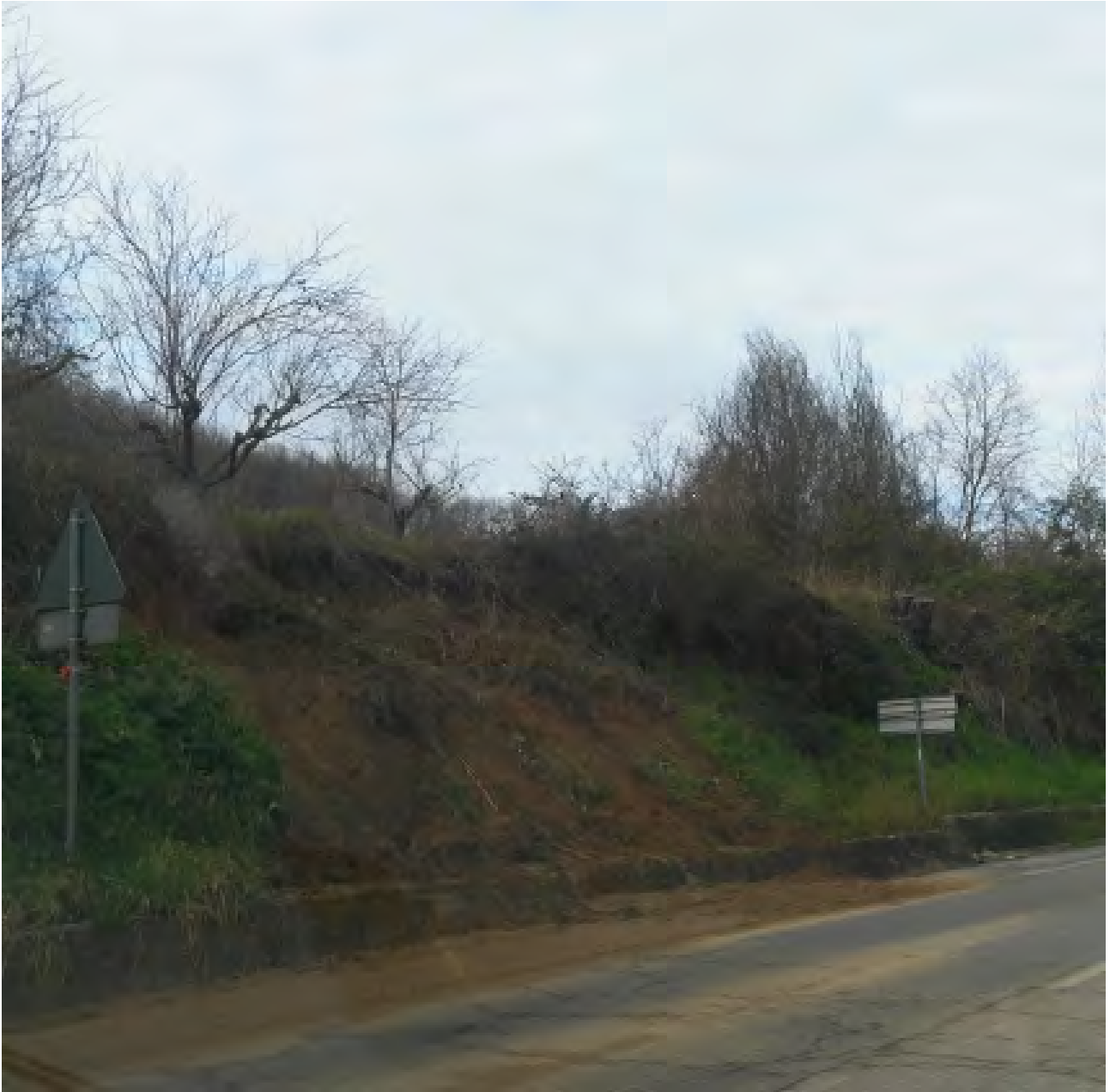
Figura 16: Smottamento lungo strada nella valle del Foglia
